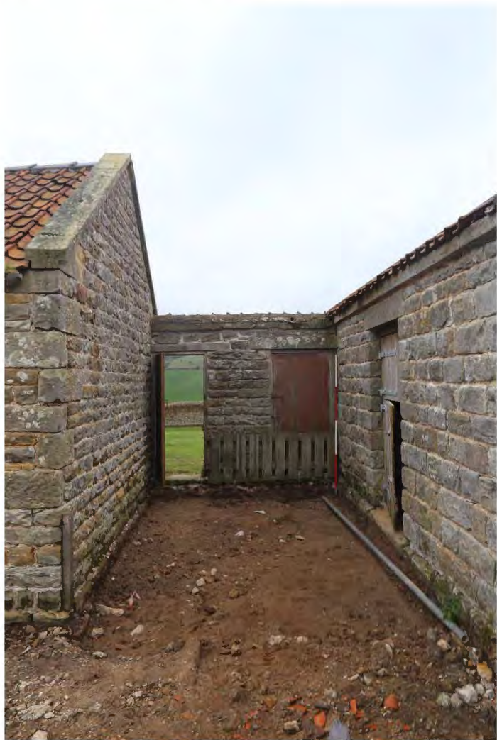
047_1050_boundary wall and door
